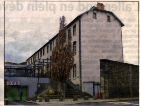
Le bâtiment qui abrite les cuisines et le restaurant du troisième âge, aux trois-quarts vide et en mauvais état, va être vendu à l'ADAPEI, qui va y aménager des logements adaptés au public porteur de handicaps dont elle s'occupe.
